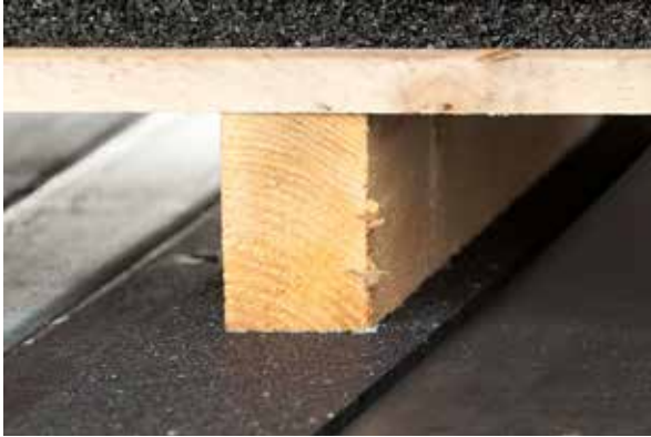
Colocación del palet encima del antideslizante de goma
