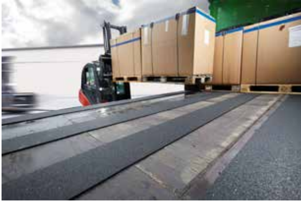
Colocación del antideslizante de goma
