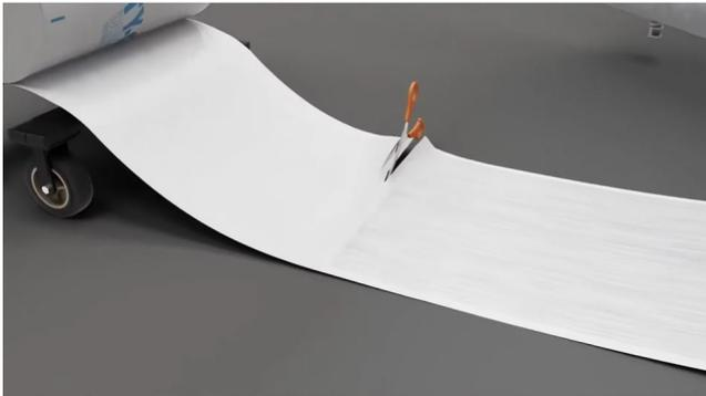
Cortar 2 trozos de Ty-Gard2000 por cada barra que necesitemos (Se necesitan 3 metros por cada lado (1'5 mts. con adhesivo y 1'5 mts. sin adhesivo)).
